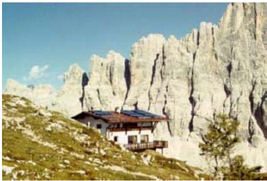
Impianto fotovoltaico per utenza isolata
