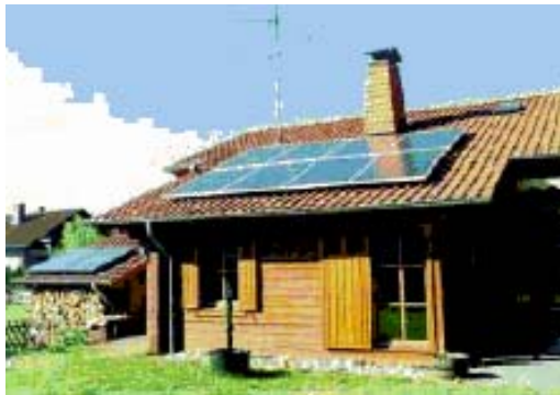
Impianto fotovoltaico collegato alla rete
